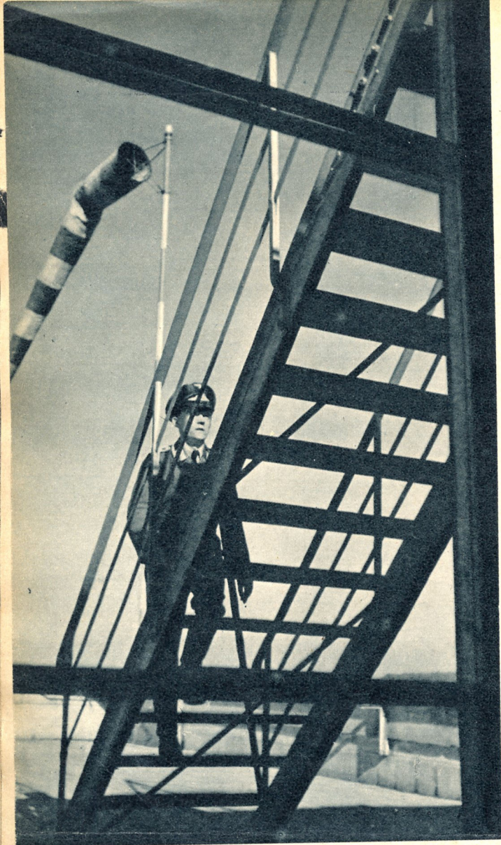
Der Aufgang zum Befehlsgebäude der Luftkriegsschule. Im Hintergrund der Windsack, der die Windrichtung anzeigt
