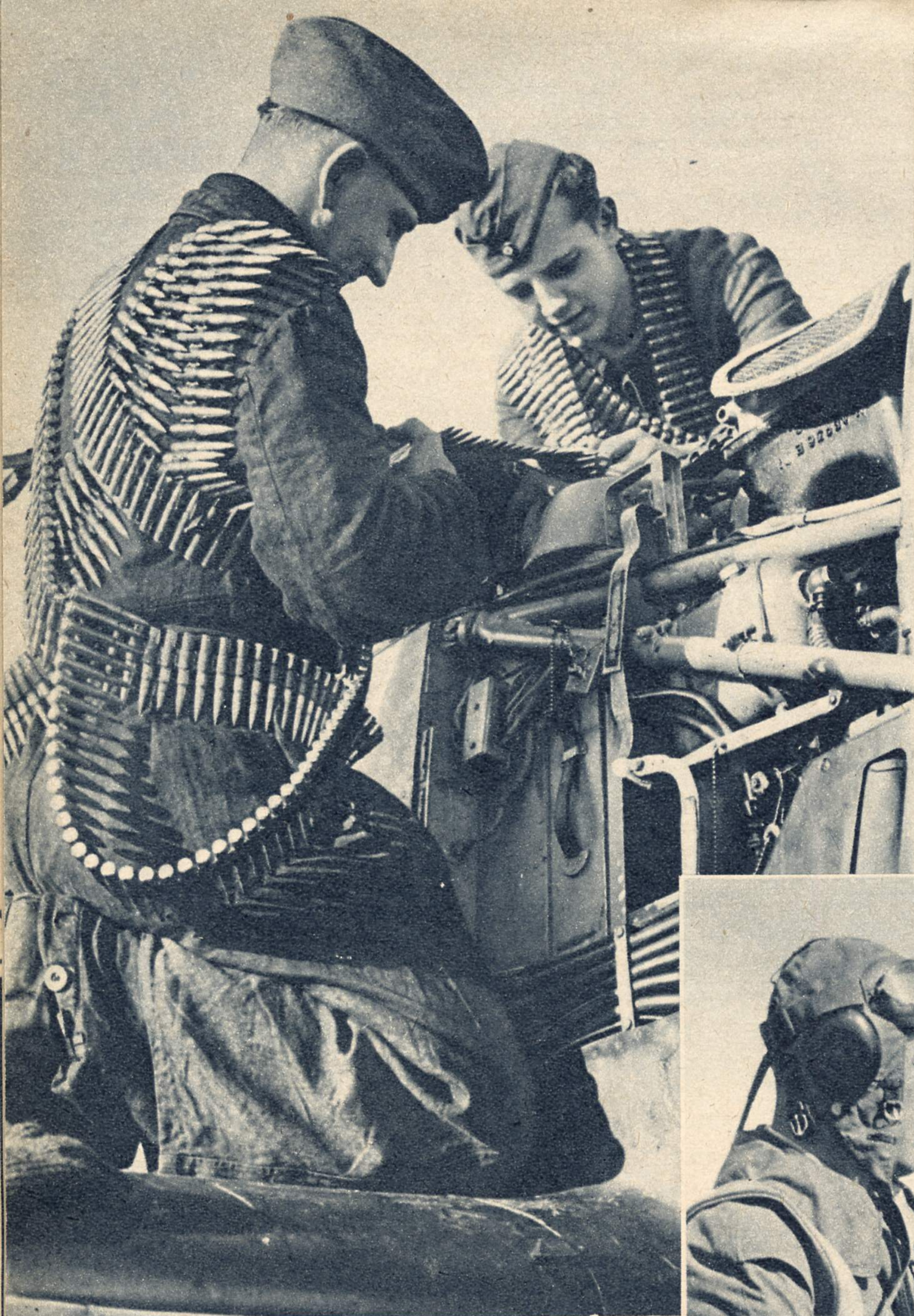
Es sieht sehr malerisch aus, hat aber einen sehr ernsten Hintergrund: Das Waffenpersonal versieht die Bordwaffen eines Jagdflugzeuges mit den Patronengurten. Von der sorgfältigen Arbeit des Waffenpersonals sowohl beim Gurten der Munition als auch beim Laden hängt das einwandfreie Arbeiten der Bordwaffen und damit die Sicherheit des Jägers weitgehend ab
