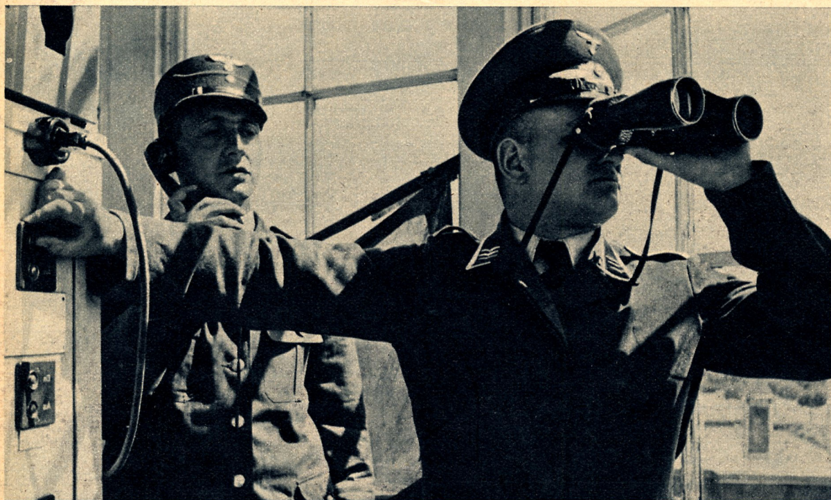
Von der Brücke des Kommandoturms beobachten die Beamten der Reichsluftaufsicht die Bewegungen der zur Landung hereinschwebenden und der sich zum Start begebenden Flugzeuge. Noch ist der Start nicht frei. Ein Druck auf den Knopf, das rote Blinklicht leuchtet auf, und der Beamte draußen am Startplatz muß so lange mit dem Flaggenzeichen zur Freigabe warten, bis ihm vom Kommandoturm durch grünes Lichtzeichen der entsprechende Befehl erteilt worden ist
