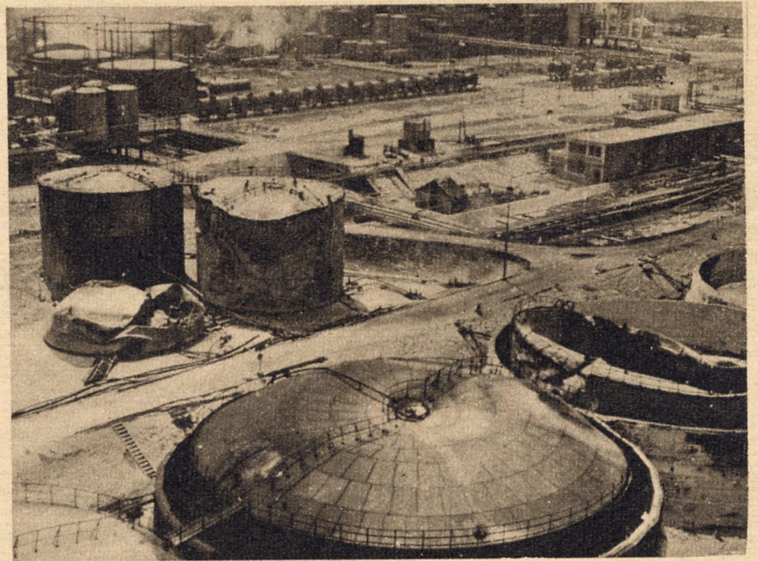
Einige Petroleumtanks nach dem Brande. Die durch Bomben unmittelbar getroffenen Behälter sind zerrissen und zusammengedrückt. Im Hintergrund stehen gefüllte Tankwagen, die der Brand verschont hat
