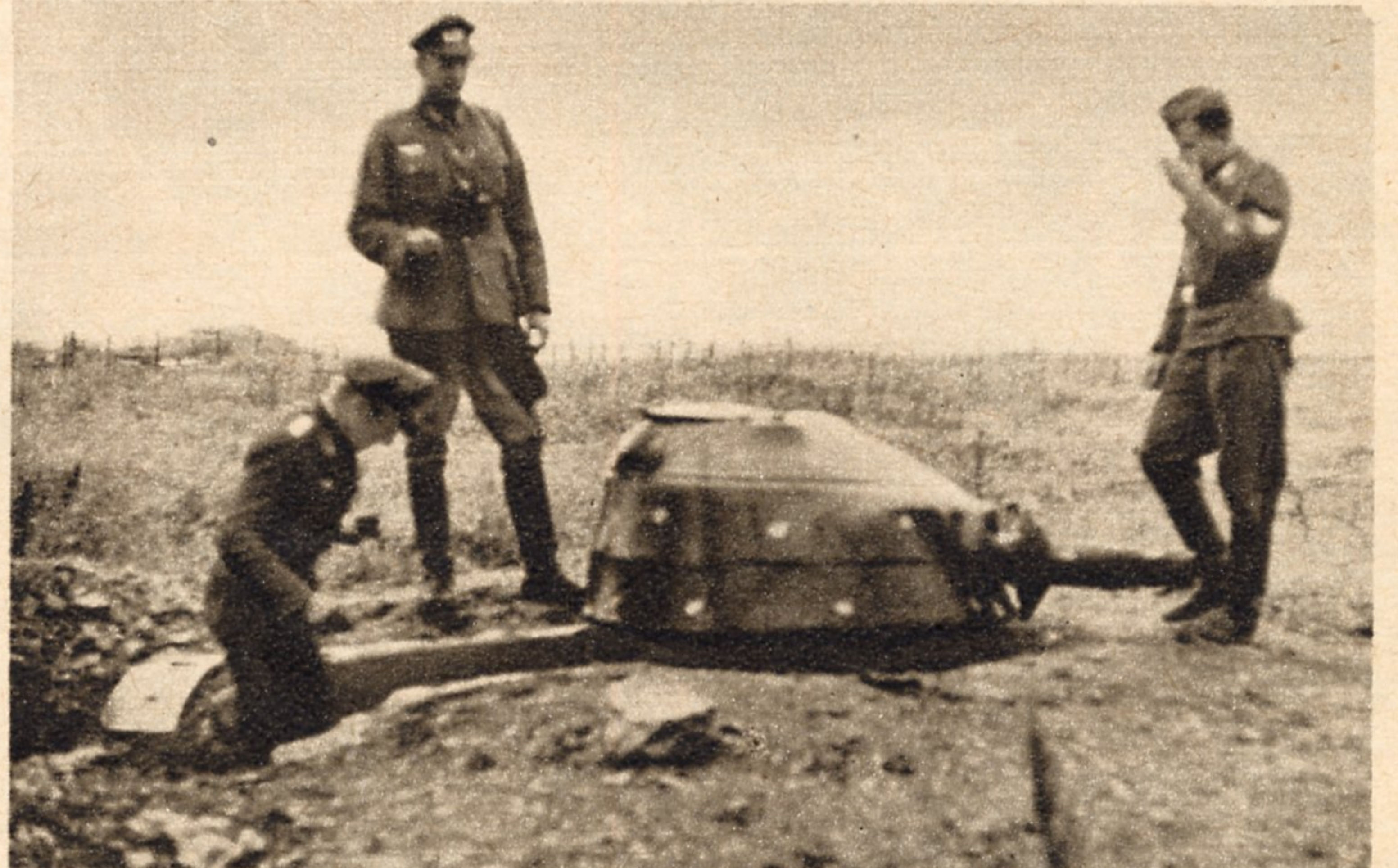
Auf vielen beherrschenden Höhen ist die Maginotlinie durch solche Einmann-Panzer verstärkt. Sie sind mit einem allseitig drehbaren Geschütz bestückt und waren mit nur einem Mann besetzt. Der hier abgebildete Panzer ist unversehrt gefallen, nachdem die umliegenden Werke im Stukafeuer genommen worden waren
