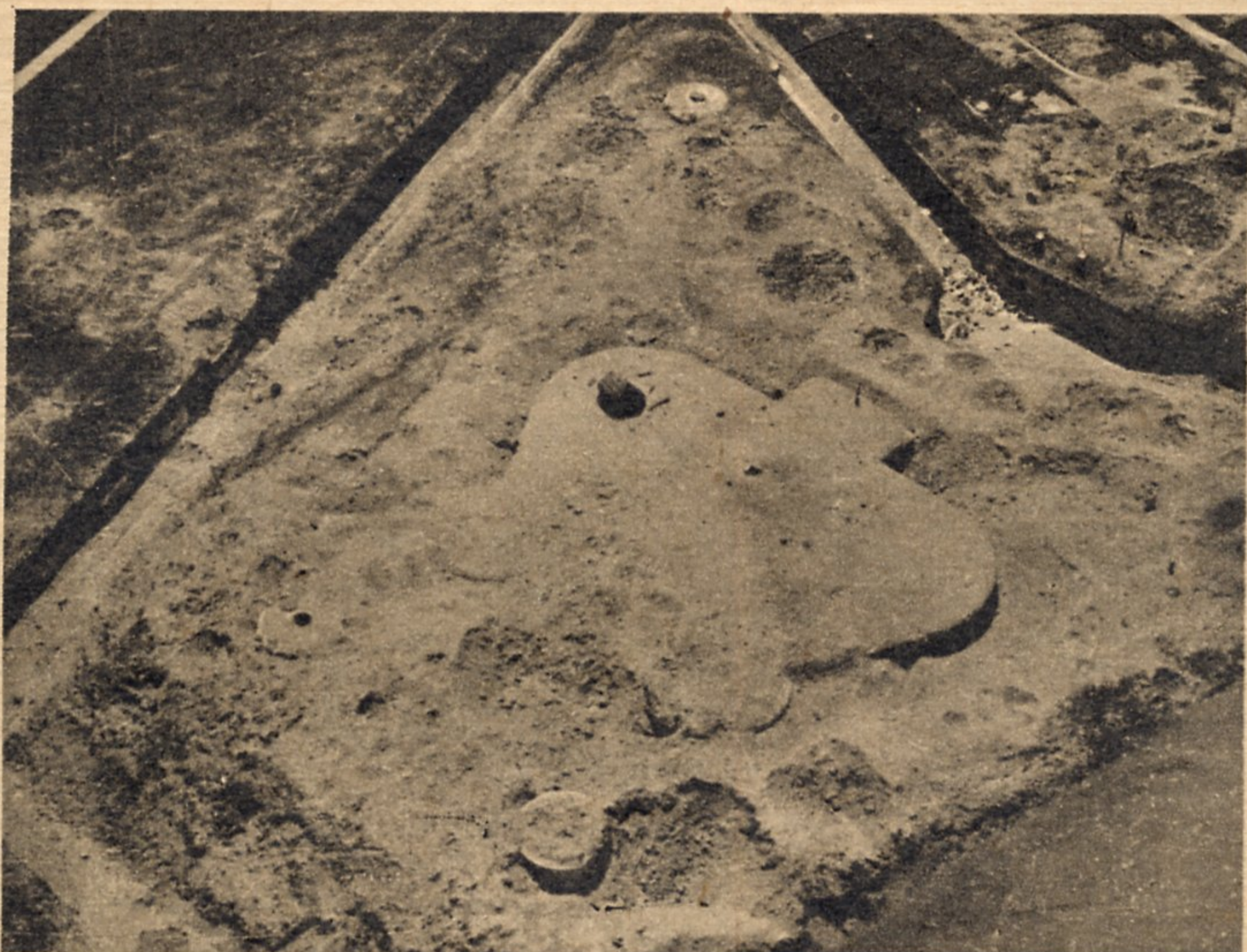
Hier haben, das verrät sich auf den ersten Blick, deutsche Stukas gewirkt. Es ist ein Panzerfort der Festung Lüttich. Auf dem Kernwerk liegt eine viele Tonnen schwere Panzerkuppel, die durch die Explosionswirkung der Stukabomben abgehoben und beiseitegeschleudert worden ist
