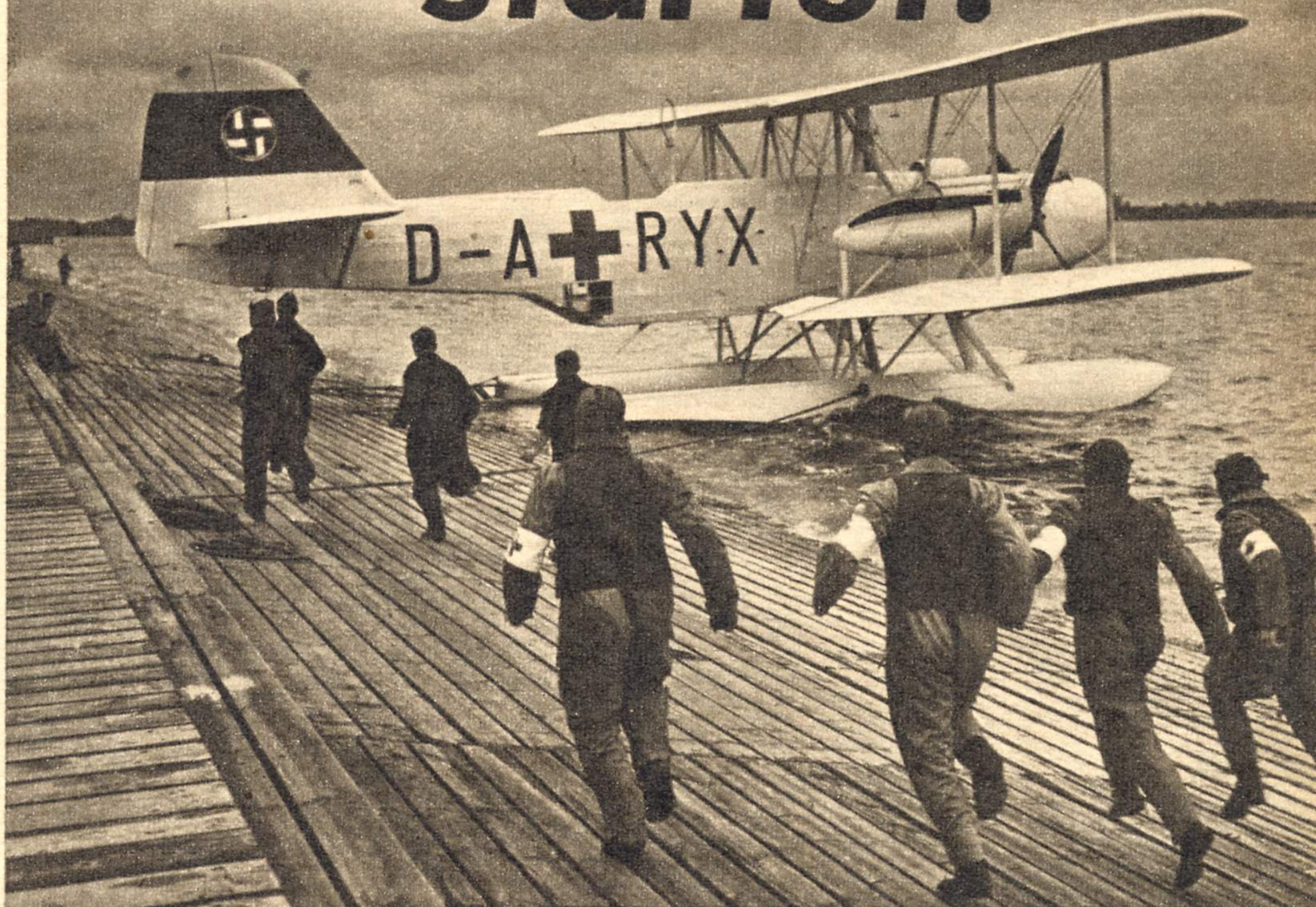
Immer bereit zum Einsatz sind die Mannschaften unserer Seenotflugzeuge. Kaum ertönt das Alarmsignal, da eilen Flugzeugführer, Beobachter, Funker und Bordwart sowie Bodenpersonal auch schon zur Maschine. Rasch wird diese, wie unser linkes Bild zeigt, aus der Halle gerollt, wo sie startbereit stand, und (Bild ganz unten links) zu Wasser gebracht
