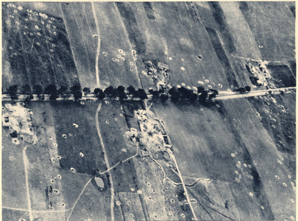
Eine Bunkeranlage, die die Landstraße, einen wichtigen Zugangsweg zur Festung, völlig beherrschte, ist vernichtet; wir sehen ihre Trümmer unterhalb der baumbestandenen Straße. Ausgebrannte Gehölze zeigen, daß sich der polnische Rückzug in gleicher Weise wie an allen Kampfstätten abgespielt hat: Rauchende Trümmer kennzeichnen den Rückzugsweg. Das Feld ist mit Schützenlöchern ganz besät
