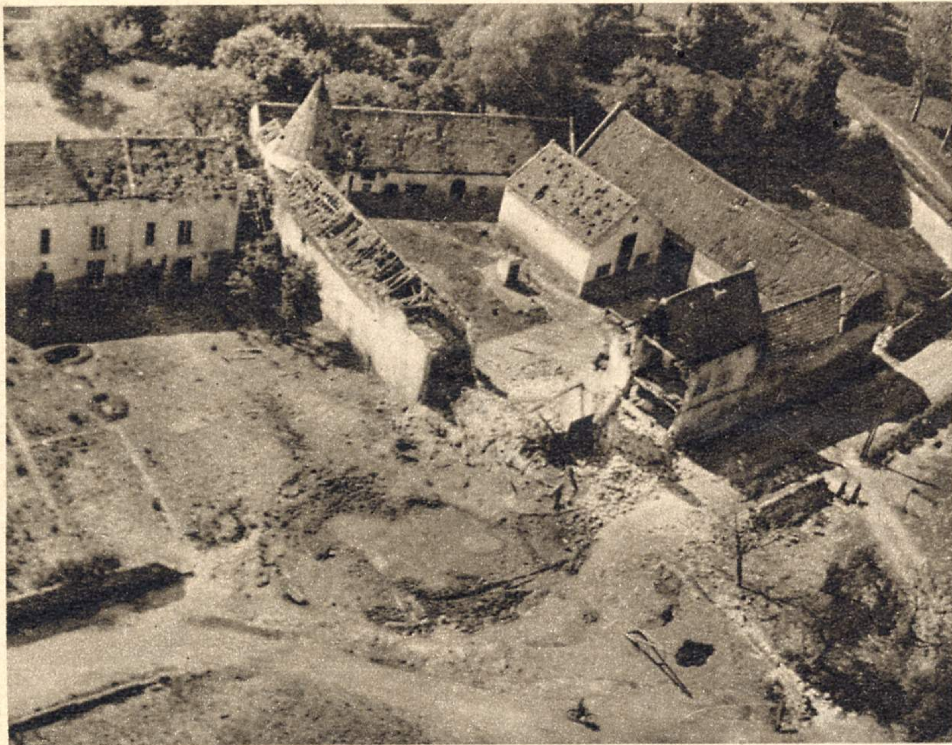
Dieses Gehöft steht in unmittelbarer Nähe eines belgischen Festungswerkes. Eine Stukabombe hat es teilweise zerstört
