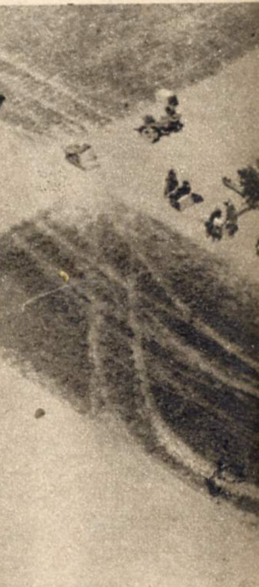
Zum Bilde links: Wo die Graben in unmittelbarer Nähe von Wohnhäusern angelegt werden, da ist es nicht möglich, die Häuser zu schonen. Die Fliegerbomben, die die belgische Grabenbesatzung vernichteten und vertrieben, haben auch die Häuser in Mitleidenschaft gezogen
