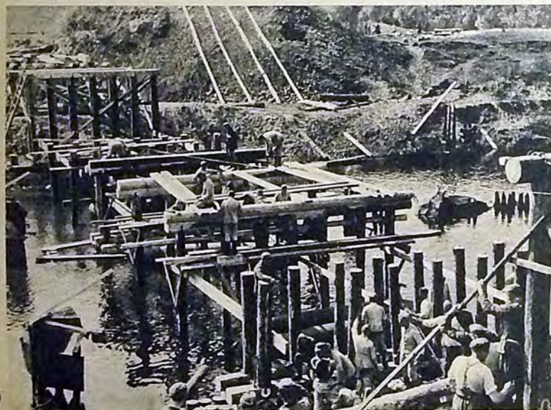
3. Tag: Über Nacht wurden Pfähle eingerammt. Mittags ist man schon dabei, die Sattelhölzer aufzusetzen
