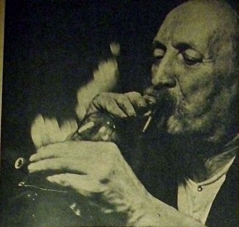
Il cannello corto. Il procedimento è il medesimo, soltanto l'oggetto è più piccolo. La massa di vetro viene alternativamente soffiata ed agitata
