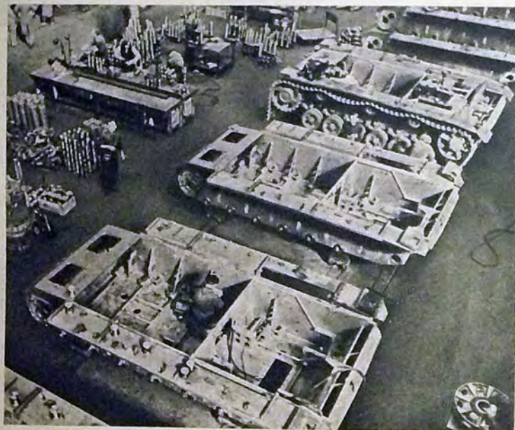
2. Mächtige Eisenkästen bilden die Urform des Panzerwagens. Aus ihnen entwickelt sich in kürzester Zeit jene Waffe, die sich im bisherigen Verlauf des Krieges als beste bewährt hat. Daneben entdeckt die Kamera bereits... Enormi cassoni di ferro formano lo scheletro del carro armato. Da essi si sviluppa in brevissimo tempo quell'arma, che si è mostrata sì efficace nel corso della guerra. Vicino la macchina fotografica scopre già...
