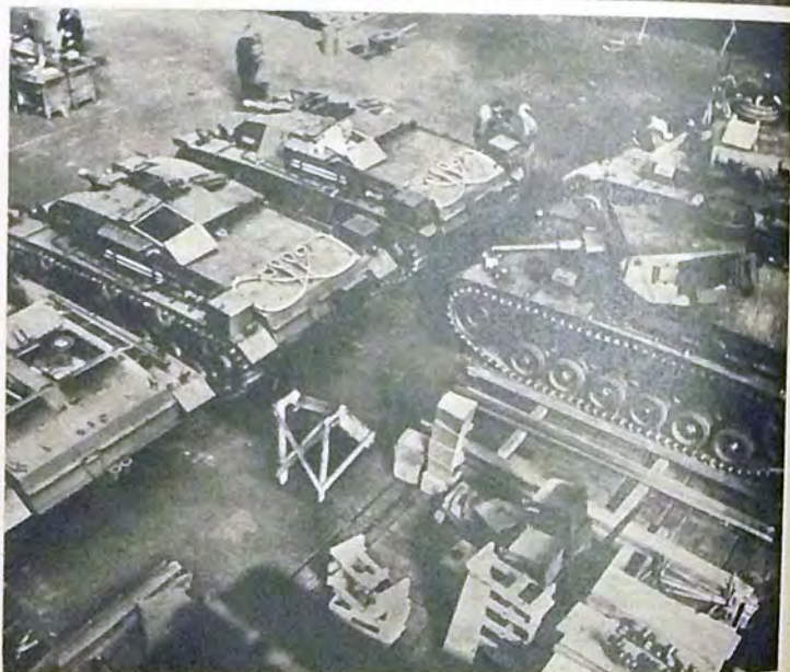
3. Am Ende des laufenden Bandes. Nachdem auf das Fahrgestell der obere Teil des Panzerwagens aufgesetzt worden ist, sind nur noch wenige Handgriffe notwendig. Und ist...
