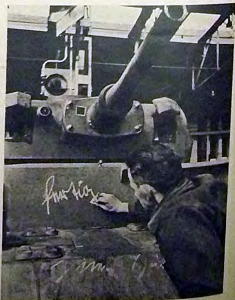
3. Am Ende des laufenden Bandes. Nachdem auf das Fahrgestell der obere Teil des Panzerwagens aufgesetzt worden ist, sind nur noch wenige Handgriffe notwendig. Und ist...
