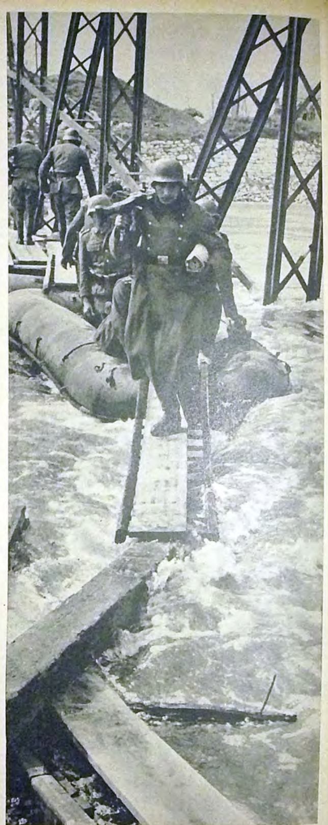
Ein Beispiel für die besonderen Geländeschwierigkeiten, die die Truppen zu überwinden hatten. Oben: Gummi statt Eisen. Pioniere haben einen Behelfssteg gebaut. Bild unten: Ein Tankschlepper „trägt“ den schweren Panzer
