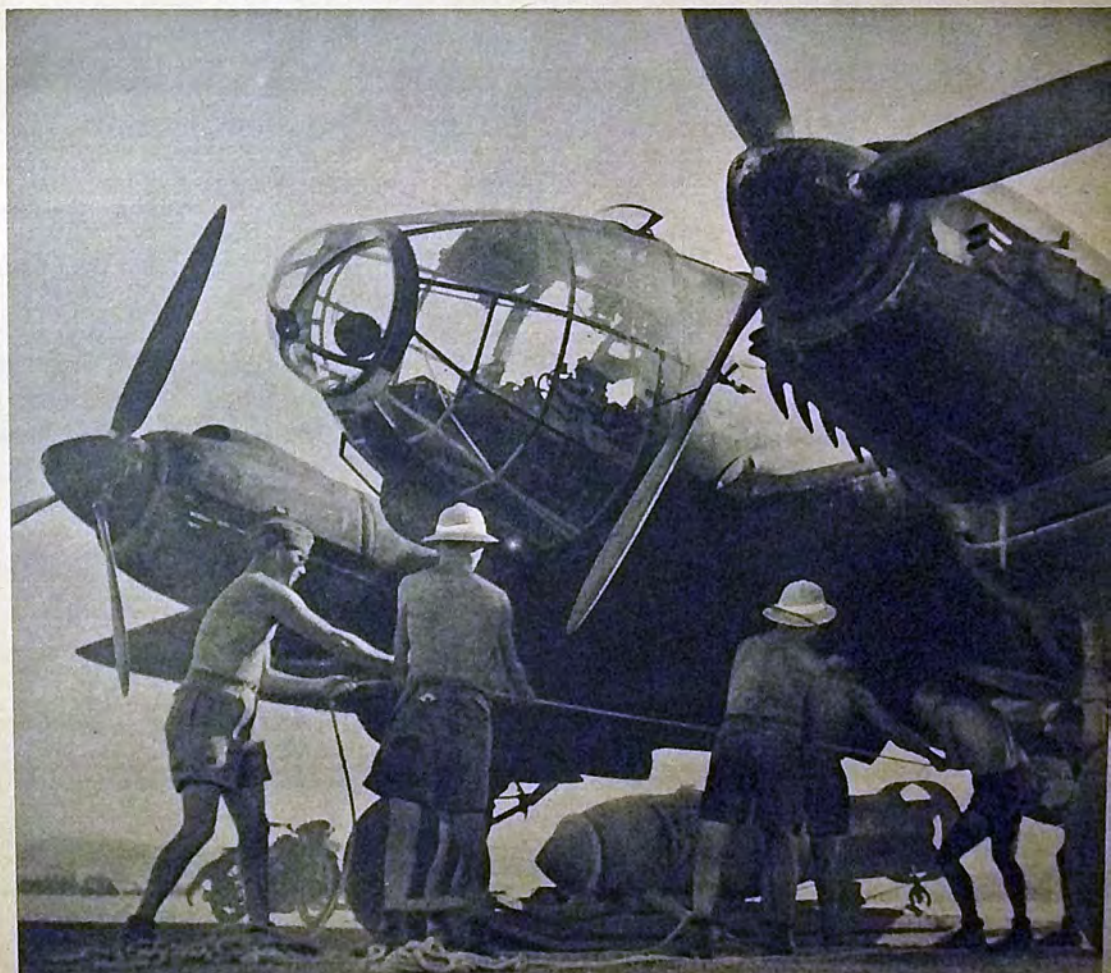
Bombe per la notte vengono caricate sotto il sole incandescente del Mediterraneo. Esse vengono trasportate vicino all'apparecchio sopra una slitta di legno. Da ultimo queste pesanti pillole vengono sollevate per mezzo di carrucole, dalle braccia di parecchi soldati, fino all'apparecchio
