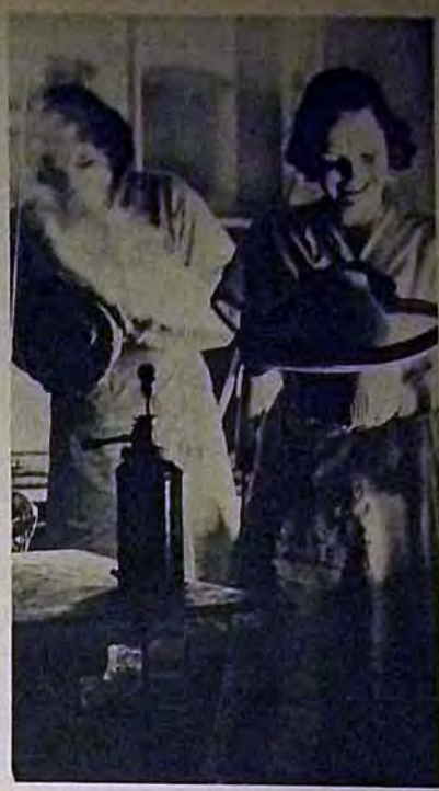
Nella «fonderia». La forma di un cappello viene immersa nel gesso. Dopo che questo primo modello si è indurito, vengono lavorate tutte le altre ordina-zioni di questo cappello. In alto a destra: La soffiatura. Qui il materiale viene dilatato, tirato e gli viene data la forma, sinché è reso flessibile
