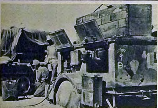
La grande dinamo, azionata da un motore Diesel, anima tutto l'autoparco, poichè è essa a fornire, per mezzo di lunghi cavi, l'energia elettrica alle singole officine mobili
