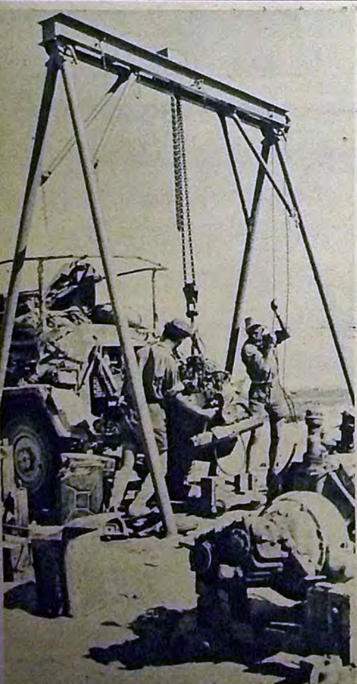
I soldati di questa officina del deserto sono degli abilissimi meccanici. Qui li vediamo accingersi a smontare il motore di un carro da ricognizione. Essi conoscono ogni tipo di motore
