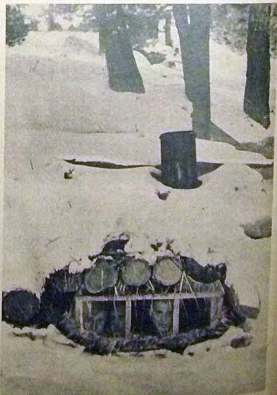
Nel ricovero. A 30 metri dai posti avanzati, i soldati germanici costruiscono dei ricoveri provvedendoli di stufe e perfino di buvette
