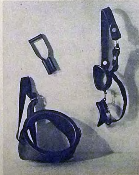
Um unter Wasser sehen zu können verwendeten Hans Hass und seine Kameraden zumeist die kleinere, hängende Brille, die wasserdicht abschließt. Wenn sie sehr tief tauchten, benutzten sie die größeren Augengläser, die bis unter die Nase gehen
