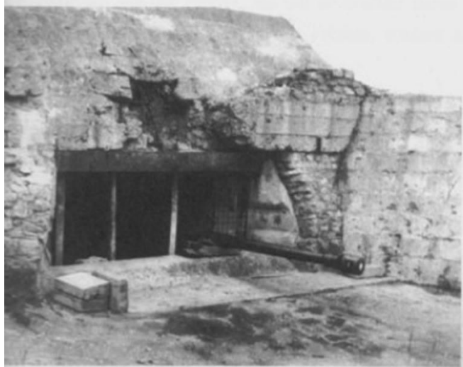
Zerschossene Kasematte WN 72 ,8,8cm Pak, in Vierville sur Mer
